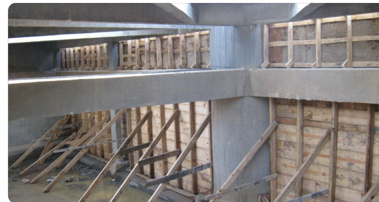
Execução de cortina em concreto como divisória
