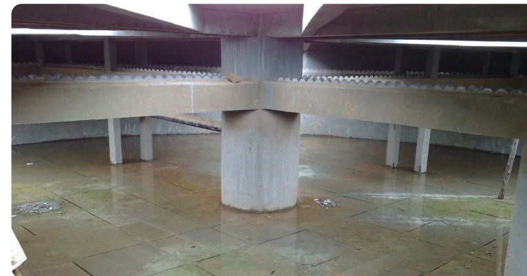
Esvaziamento do reator anaeróbio de fluxo ascendente
