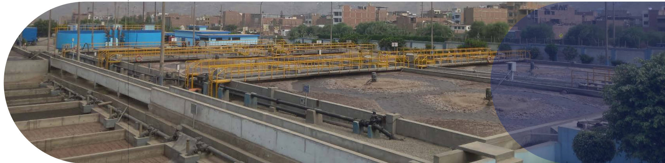
Diagnóstico energético realizado na ETE San Antonio de Carapongo (Perú)
