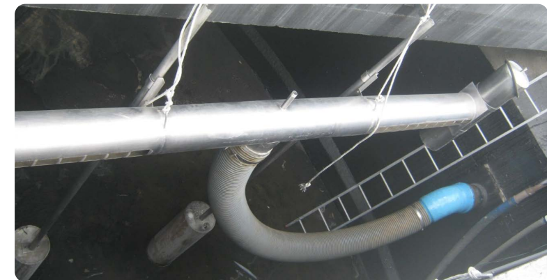
Instalação de Equipamentos:
