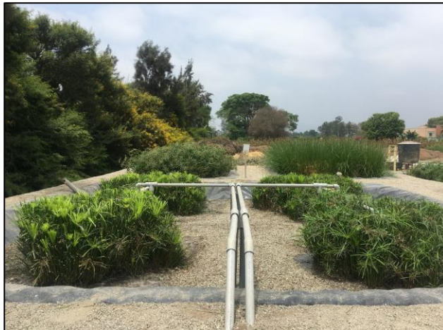
Figura 11 – Fito Filtro, após reforma no sistema de distribuição de esgoto bruto em 2018 Figura 12 – Wetland de fluxo vertical (WFV) e horizontal (WFH) em 2020
