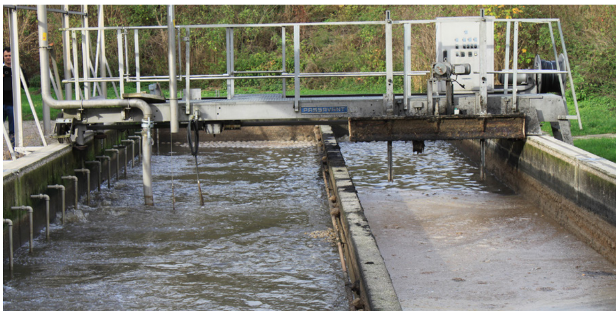
Figura 3.7: Foto de um desarenador aerado com retirada simultânea de gordura.
