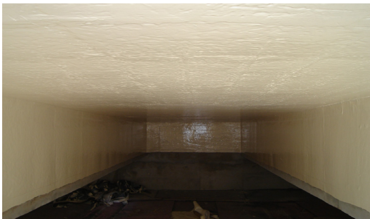
Figura 3.15: Foto da câmara de gás de um reator UASB impermeabilizada com Polibrid.
