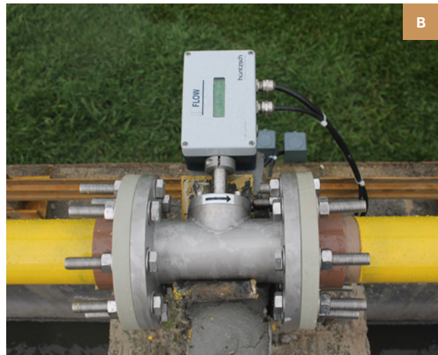
Figura 5.6: Medidores de vazão de biogás: a) e b) Tipo Vórtex; c) tipo mássico por dispersão térmica.
