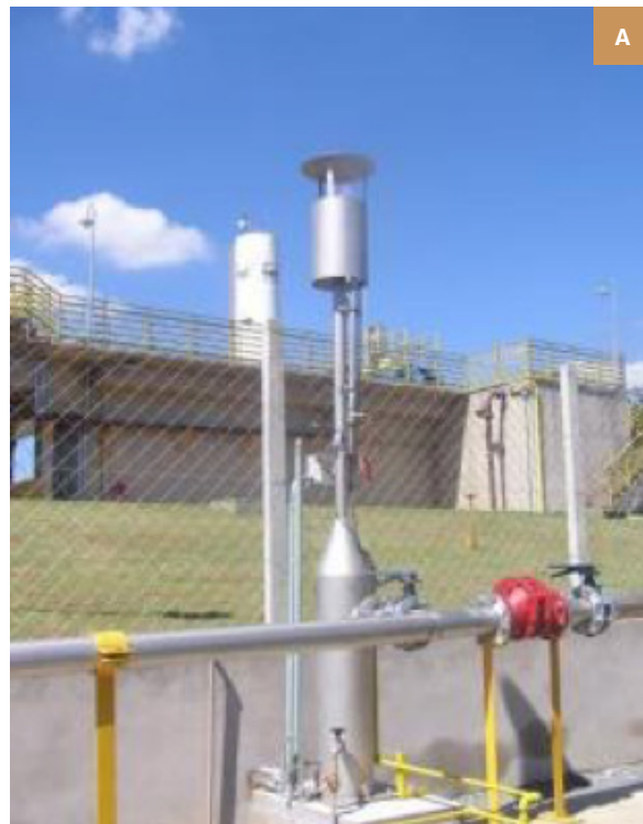
Figura 7.1: Foto de Queimadores: [a] aberto; [b] enclausurado; [c], [d] semi-enclausurado; [e] Dampers de flare enclausurado.
