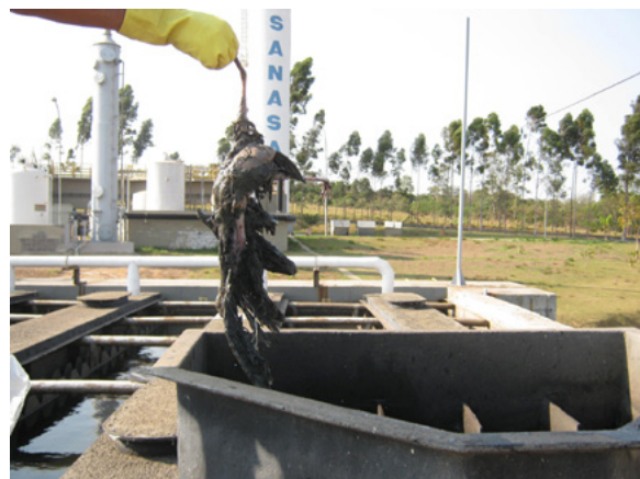
Figura 3.6: Remoção de resíduos na caixa de distribuição de efluente dos reatores UASB.
