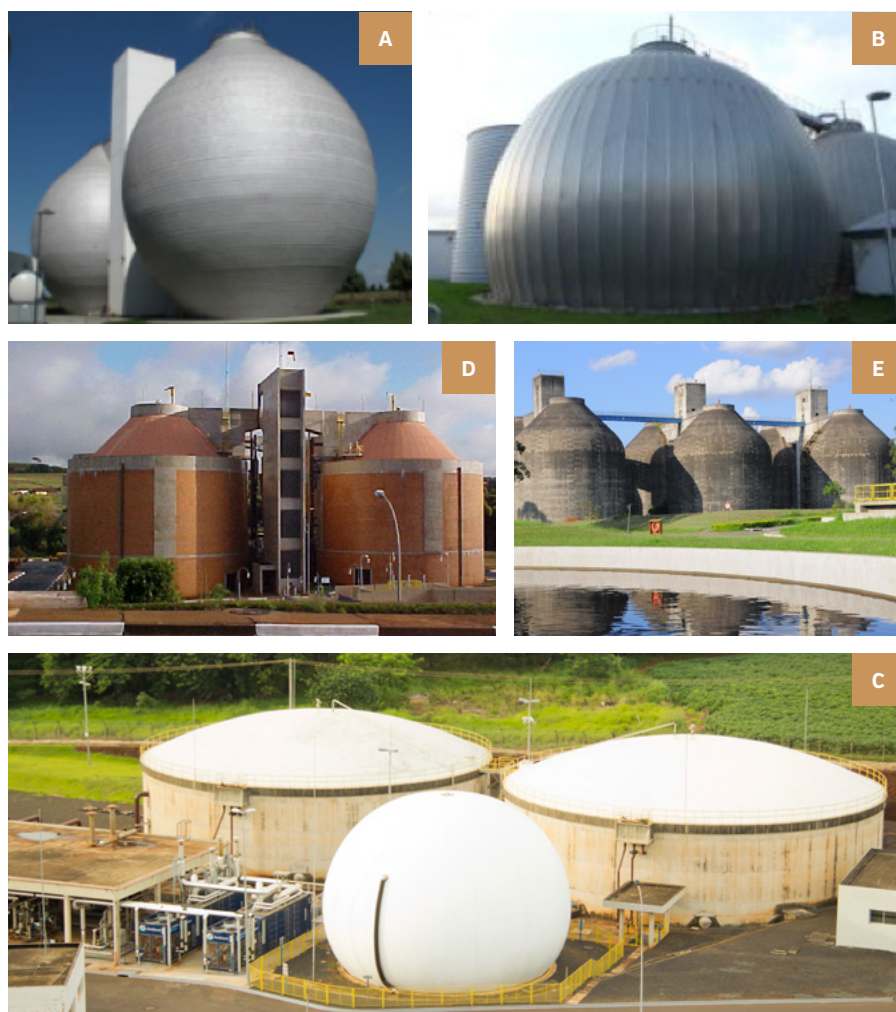
Figura 3.20: Fotos de digestores de lodo: (a) forma oval na ETE Wassmansdorf - Alemanha; (b) ETE Neckarsulm - Alemanha; (c) Serviços Ambientais de Ribeirão Preto S/A [ETE Ribeirão Preto]; (d) SABESP [ETE Franca]; (e) SABESP [ETE Suzano].
