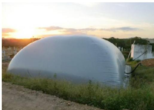
**Figura 22:** Esquema de gasômetro de membrana dupla.
