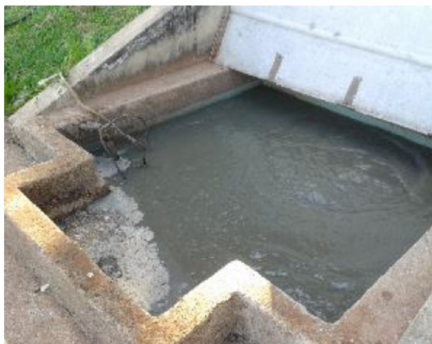
Figura 5: Bomba submersa na caixa de entrada UASB.
