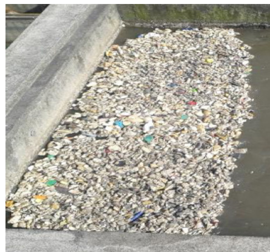
Figura 6: Acumulação de lixo na caixa de entrada de UASB.
