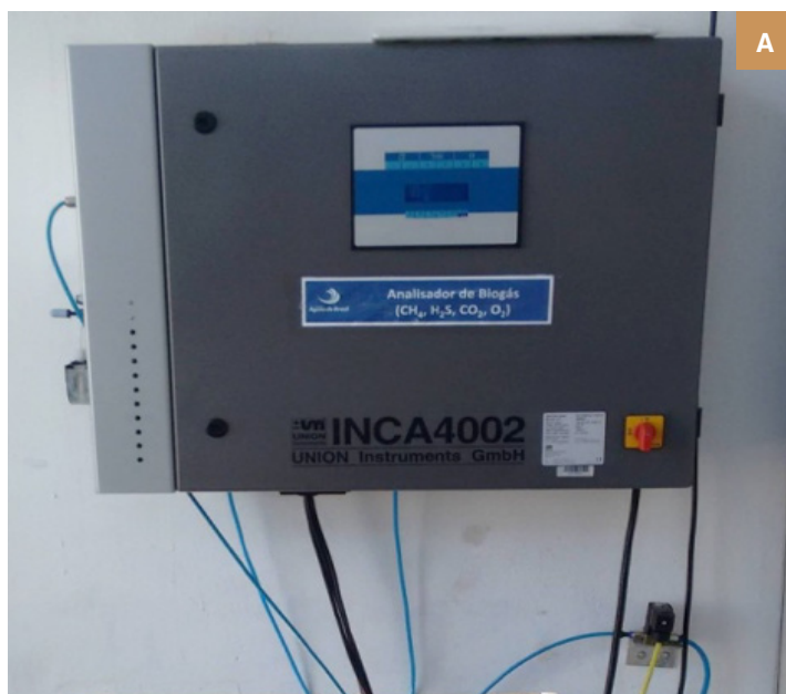
Figura 6: Medição da composição de biogás: [a] Quadro de medição da Union; [b] Tomada da amostra de gás.
