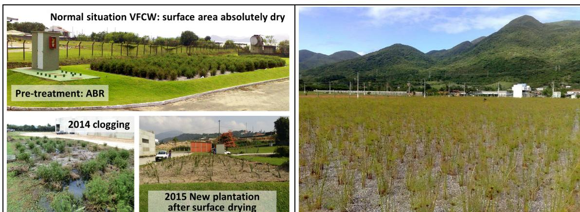
**Figure 12:** Estudo de caso ESGOTO 3 com problemas de colmatção e nova plantação
