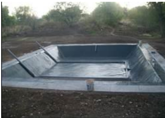
Figura 7 – Caso 4: Instalación de impermeabilización, las tuberías de drenaje
