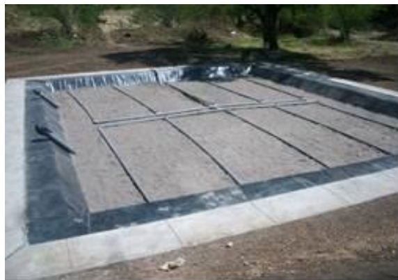
Figura 8 – Caso 4: Instalación de las tuberías de distribución
