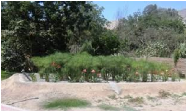
Figura 3– Caso 2: Vista de humedal recién instalado y cargado con aguas grises
