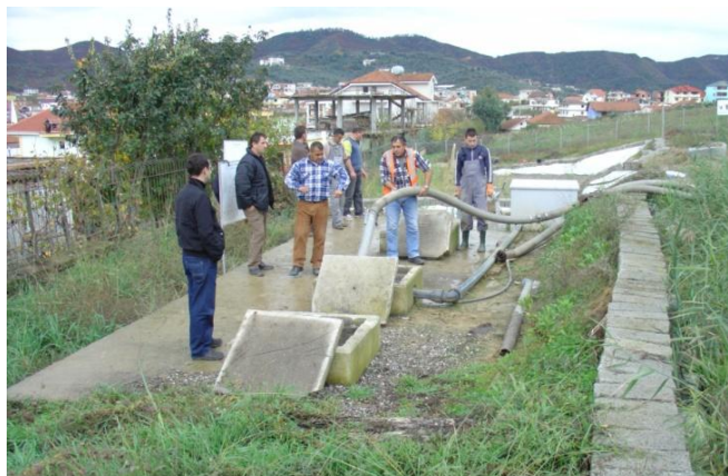
Figure 13. Procesos para sacar el lodo sedimentado del pretratamiento de un HA en Tirana, Albania. El lodo se transporta con camión cisterna para su posterior tratamiento en una planta de tratamiento de aguas residuales (proyecto apoyado por GIZ, foto J. Nowak, 2010)
