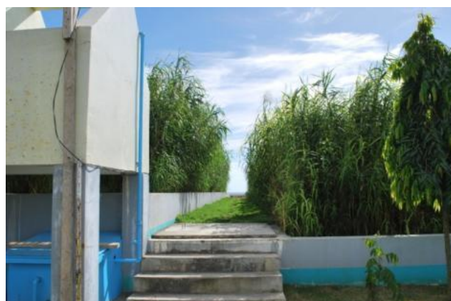
Figura 27. HA FS en la ciudad Bayawan, Filipinas. La ruta de acceso del centro separa el HFV del HFH (foto J. Boorsma 2009, proyecto apoyado por GIZ) 26 .
