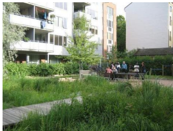
Figura 2. Tratamiento descentralizado de aguas grises urbanas en un humedal artificial de flujo subsuperficial Klosterenga en Oslo, Noruega (foto L. Ulrich, 2008).
