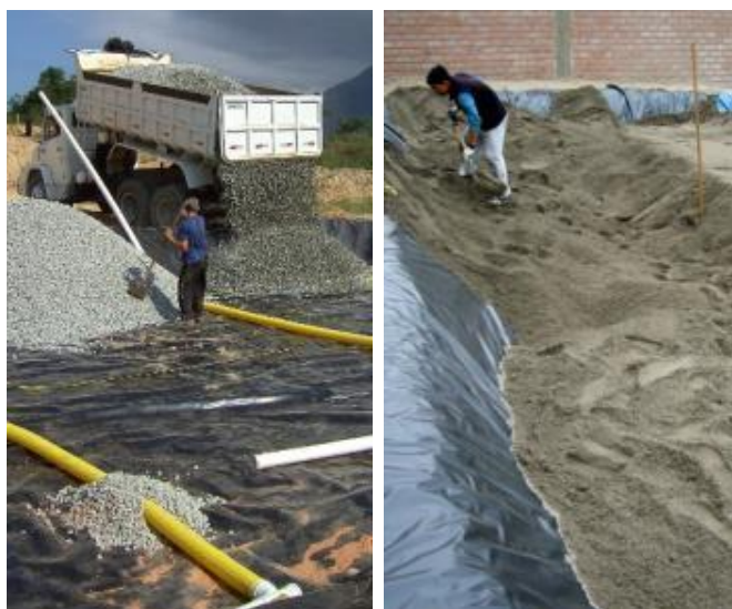
Figura 9. Izquierda: HFV durante la construcción, Brasil, Santa Catarina, ciudad Palhoça; geomembrana HDPE con tubos de dren en el fondo, cubiertos con grava. Derecha: HFV en Lima, Perú, llenado con arena (H. Hoffmann, 2007).
