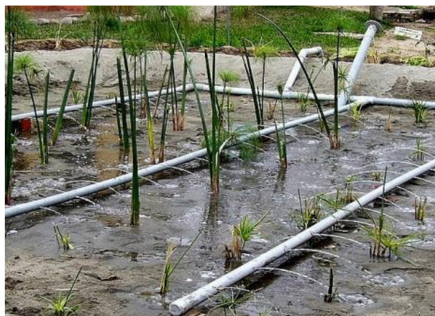
Figura 6. Humedal de flujo vertical (HFV) en Lima, Perú durante la prueba de bombeo para comprobarla distribución. El agua gris pretratada sale por pequeños orificios de los tubos de distribución. Los tubos fueron posteriormente cubiertos con grava. En el flujo vertical se utiliza toda la superficie como área de entrada. (foto H. Hoffmann, 2008).
