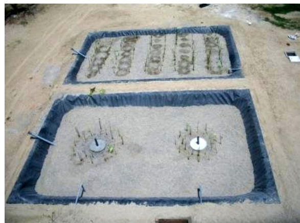
Figura 9: Start up da operação em novembro 2011
