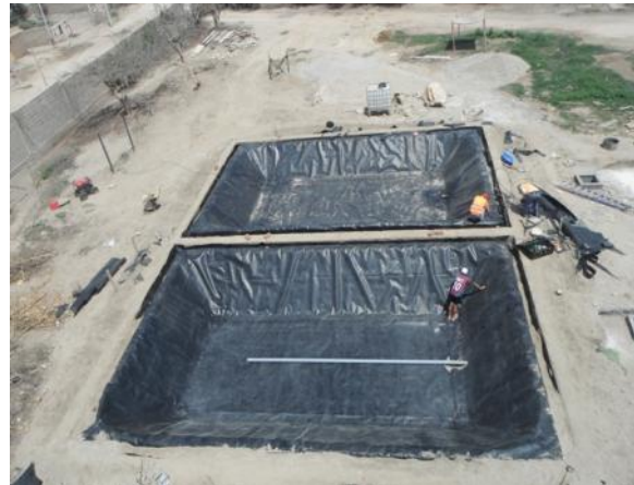
Figura 5: Impermeabilização com lona HDPE
