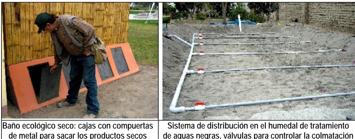
Baño ecológico seco: cajas con compuertas de metal para sacar los productos secos
