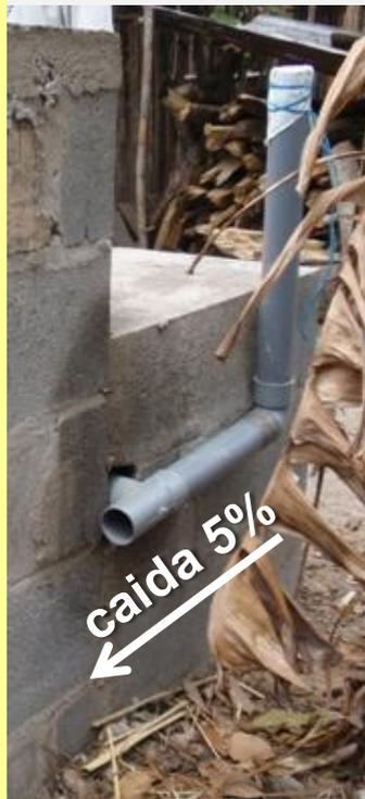
Una vez fuera se lleva la tubería hacia un reservorio o para enterrarla en el suelo, en este camino se coloca una tee (Foto 7) que permite unir la tubería del urinario.
