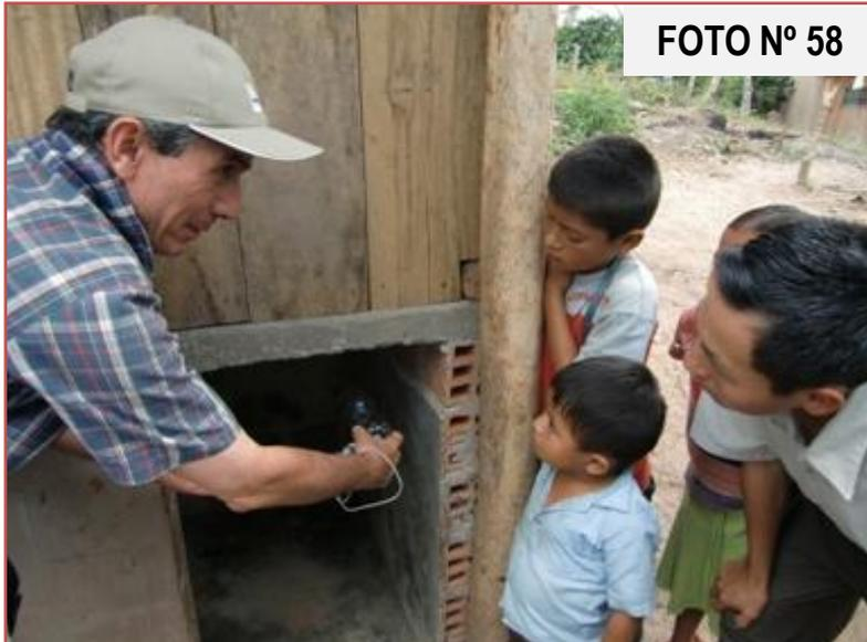
Quando se cierra las compuertas traseras, en locales o climas con muchos insectos, se recomienda colocar una trampa de moscas, la cuál consiste en una botellas plásticas de 2,2 L 1ue tiene el pinco invertido como se muestra en el esquema 5. Esta botilla se coloca con su fondo en dirección de luz, por ejemplo para dentro de barro que cierra las compuertas (fotos N° 57 y 58), en esta manera capta las moscas que entran en la cámara por el asiento.
