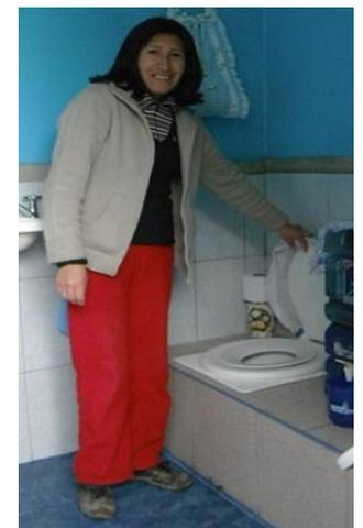
La utilización de eco-sanitario garante la desviación de orinas e posibilita que los excretas pueden secar. La orina puede ser reutilizada como urea, mientras las excretas se deshidratan en un sistema de dos cámaras con uso alterno, a humedad sale por un tubo de ventilación. Después de 2 años el producto puede ser sacado sin riesgo para la salud e puede ser reutilizado.
