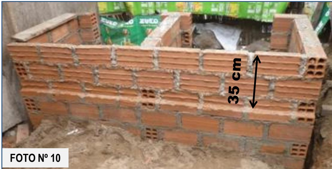
**7B. LADRILLO.-** Para disminuir el ancho de la pared, lo mas recomendable es cortar todo la pared del frente (aprovechando la condición del ladrillo pandereta) hasta la altura del futuro piso (35 cm) (foto N° 10). Otra alternativa es picar solamente los dos partes para sentar se o picar la pared de dentro para el tubo de orina.
