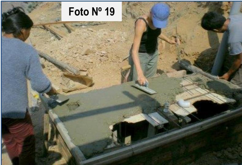
**10A. En la construcción encofrada,** la banca es preparada directamente encima de las paredes (Fotos N° 17, 18 y 19) que pueden ser de ladrillos, adobe o cloques de cemento. Se prepara una mesa apuntalado dentro de los limites de las paredes de la cámara. Esta mesa puede ser de madera, carrizo u otro material que se saca después que el cemento seco. En seguida se monta la parilla de fierro (esquema N° 4). La mezcla del concreto es: cemento, arena y piedra chancada 1:2:3.
