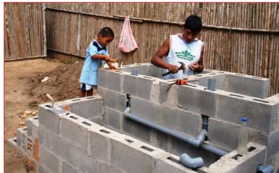
Foto N° 13: obra con tubo de orina instalado
