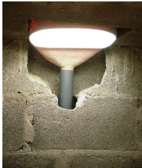
Foto N° 12: Vista interior con taza
